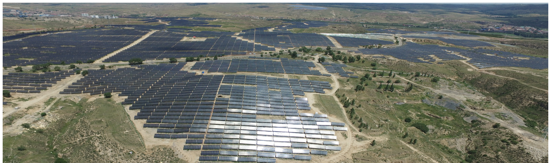
中国山西省大同采煤沉陷区“国家先进技术光伏示范基地”50兆瓦N型双面光伏电站项目
